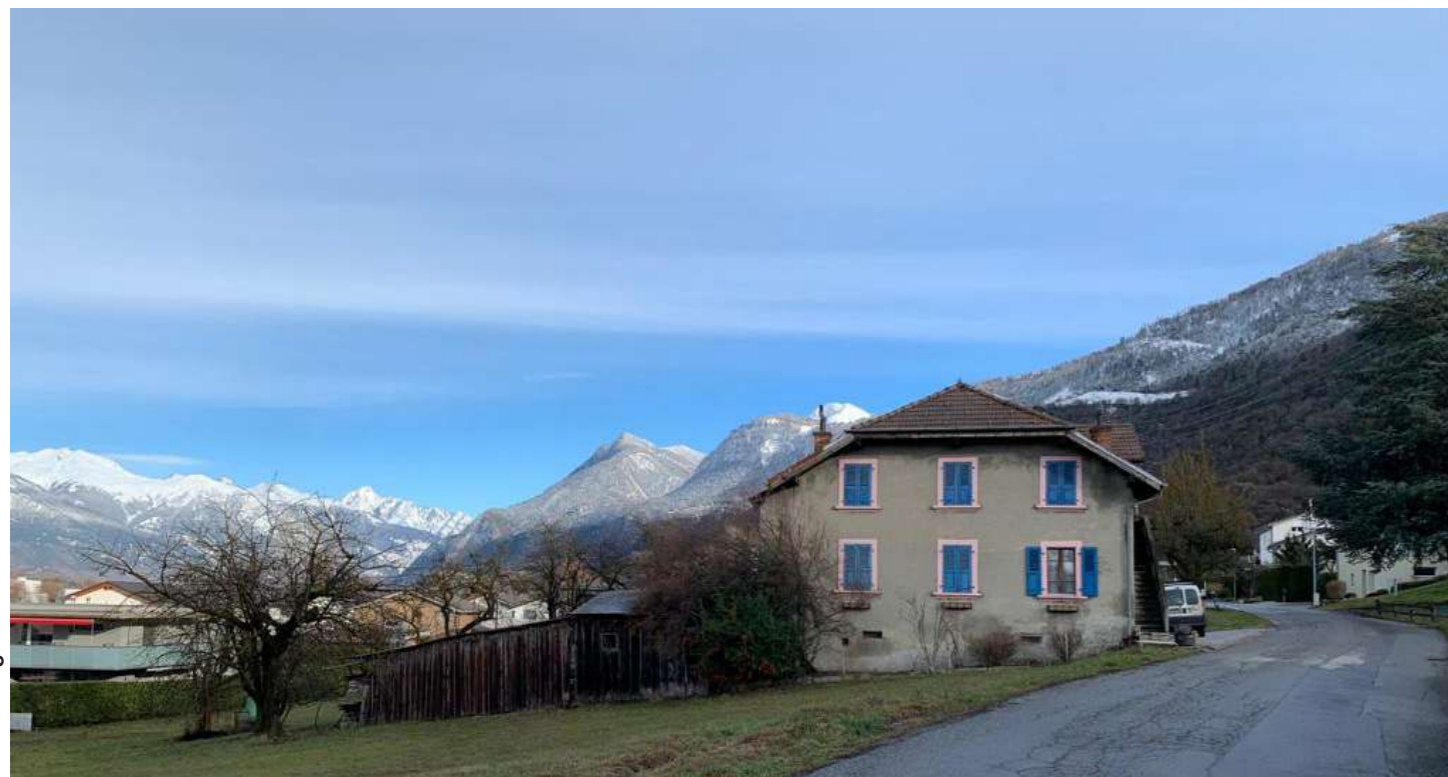
photo de l'accès et de la façade occidentale prise le 10.01.2023 par l'atelier lamie
